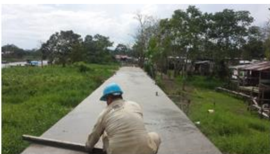
Colocación de concreto placa tramo 3
