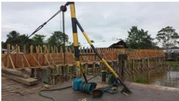
Fotografías 9, 10, 11 y 12. Armada y tundida de viga, tramo sector calle 13
