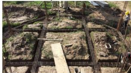
Foto 6: Instalación refuerzo viga de cimentación mirador N°2
