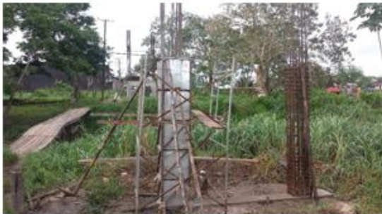
Foto 5: Colocación de concreto columna P1B (Puente colgante N° 1)
