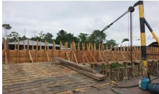
Fotografías 9, 10, 11 y 12. Armada y tundida de viga, tramo sector calle 13
