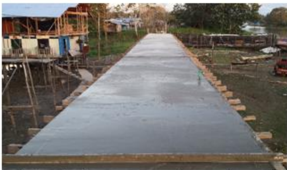
Colocación de concreto para placa en el tramo 5
