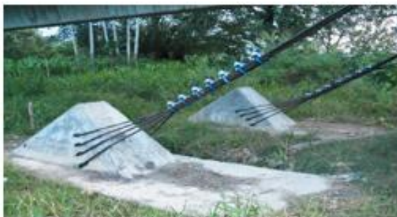
Foto 12: Anclaje del Puente N° 2
