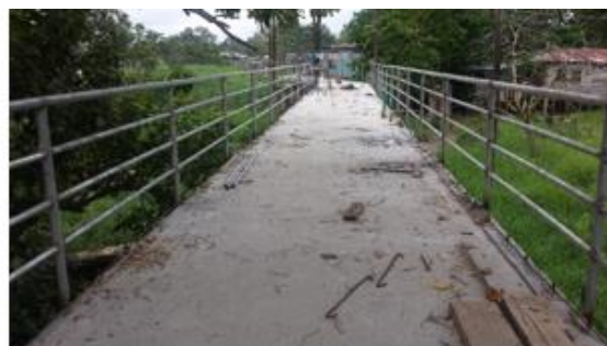
Instalación de barandas tramo 1
